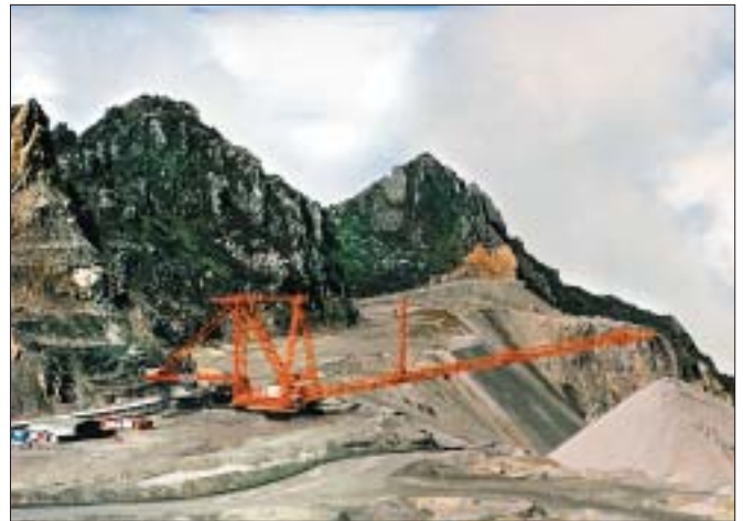
Fig. 4: Semi-mobile spreader for overburden Abb. 4: Semi-mobiler Absetzer für Abraum
