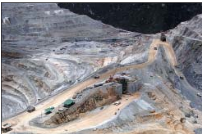
Fig. 6: View on a characteristic part of the transport route Abb. 6: Ansicht eines charakteristischen Streckenteils der Transportroute
