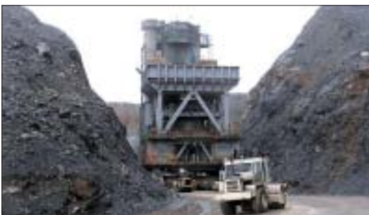
Crushing plant with 60-89" on its way to the new location Brechanlage mit 60-89" unterwegs zum neuen Standort
