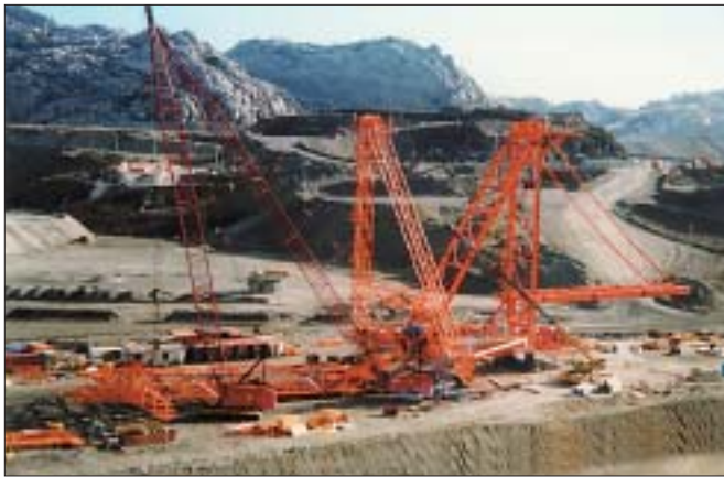
Fig. 8: Dismantling for transport Abb. 8: Demontage für den Transport
